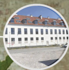
Mursten Gladsaxe Skole 1
