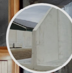
Indvædige vægge Gammel støttemur fra Vestforbrændingen Taastrup
